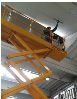
Si è deciso invece di installare un **sistema di aspirazione e campionamento** che preleva l'aria tramite delle bocchette (posizionate laddove avrebbero dovuto essere installati i puntiformi) per analizzarla in maniera centralizzata presso un armadio ubicato in una posizione più comoda, che renda veloci tutti gli interventi di manutenzione e revisione.
